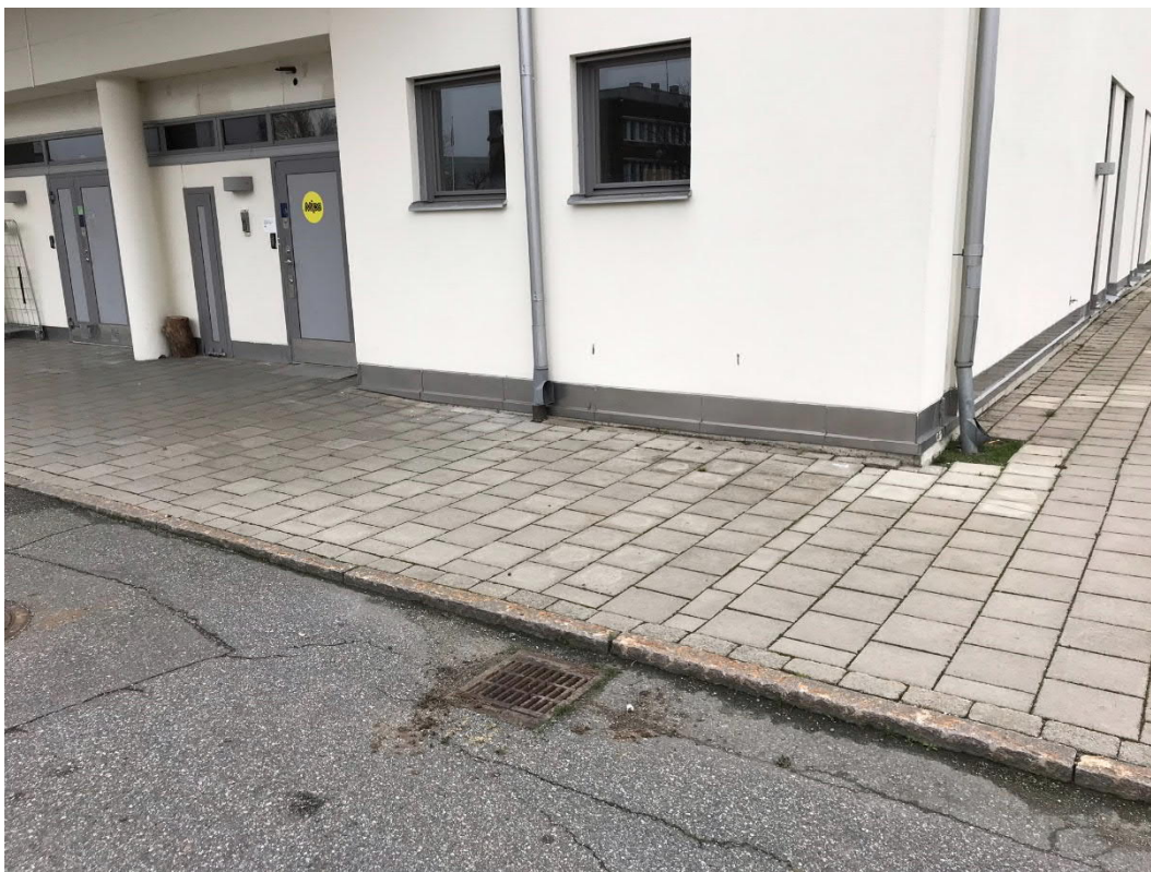
Figur 5. Kontorsbyggnad med plattläggning, sett från norr, se variation i nivå för plattläggning jämfört med vägg/sockel.
